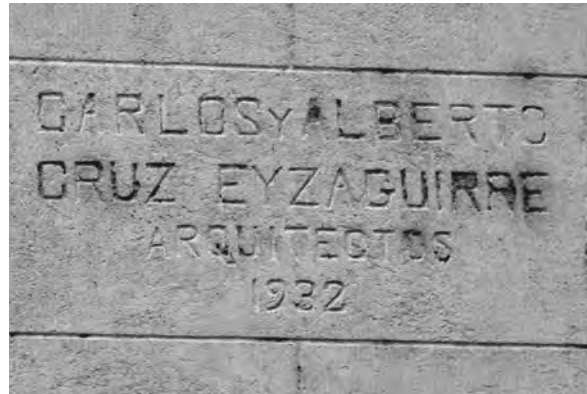
Los arquitectos Carlos y Alberto Cruz Eyzaguirre, quienes construyeron el actual edificio en 1932.
