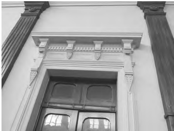
Pórtico y columnas del Club.
